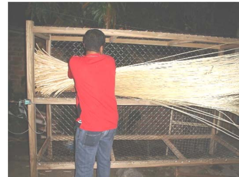
Construcción de estructura para almacenamiento Ibagué - Tolima
