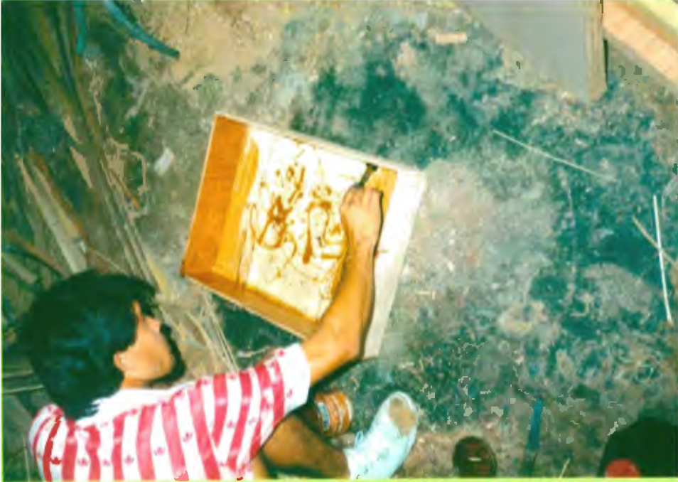
Aplicación sellador cajonería.
