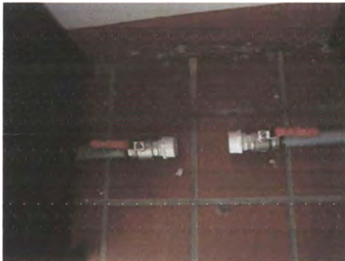
Extensión del sistema de desagüe Foto Luz Dary R Abril de 2007
