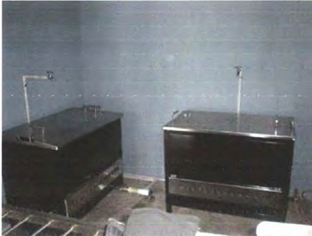
Instalación de grifería. Foto Luz Dary Rosero Abril 2007
