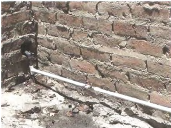
Adecuación de instalaciones hidráulica . Foto Luz Dary Rosero Abril 2007
