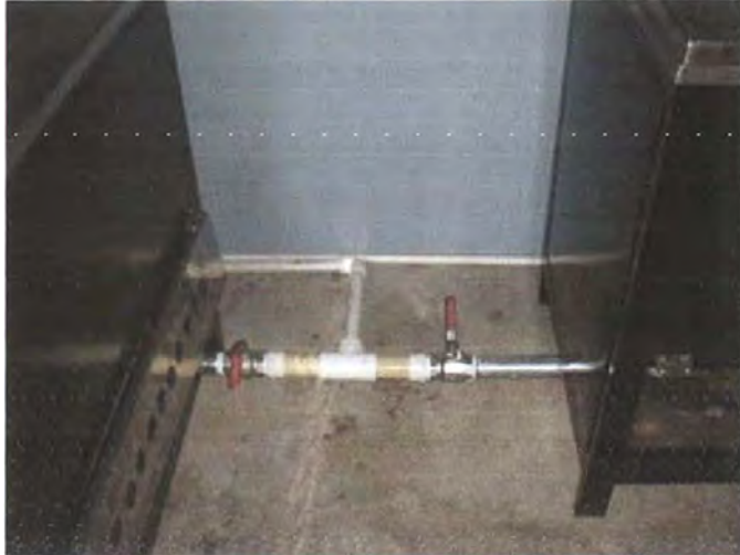
Instalación sistema de desagüe. Foto Luz Dary Rosero Abril 2007
