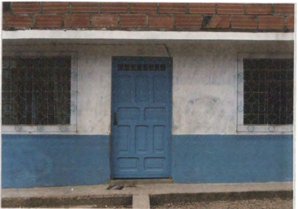
grafía #7: Fachada de la vivienda del artesano José María Ozor (1.56xK50). La mayor parte de los talleres están ubicados dentro de las viviendas. Guarne, Ant..
