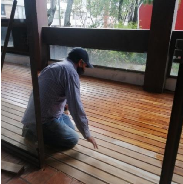
Instalación del piso en madera para exterior para la zona del balcón
