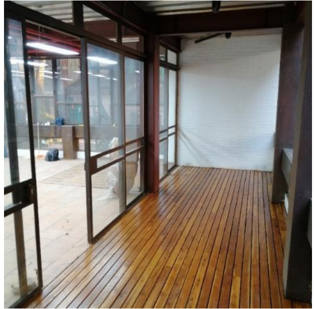
Instalación del piso en madera para exterior para la zona del balcón
